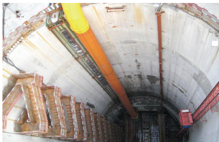
穿黄工程北岸竖井
